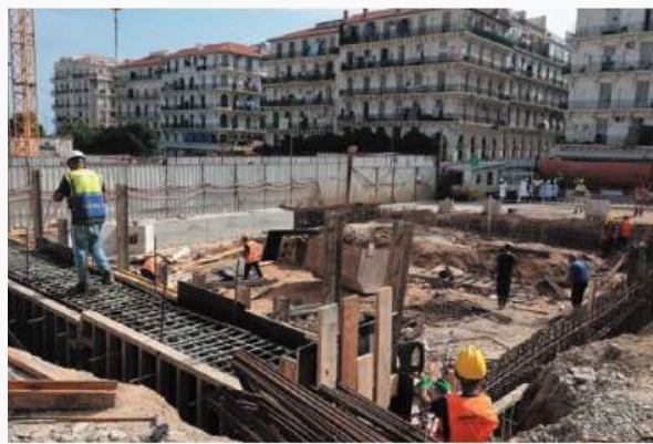
أشغال حفر النفق.
